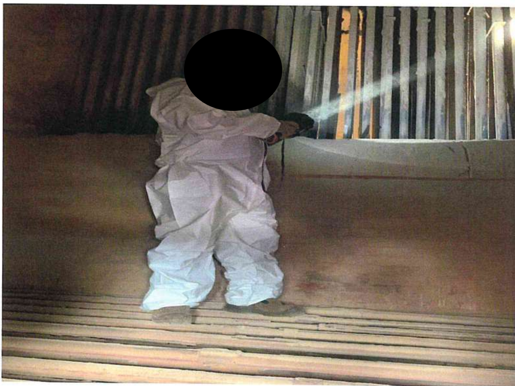
ตรวจ Secondary Superheater
