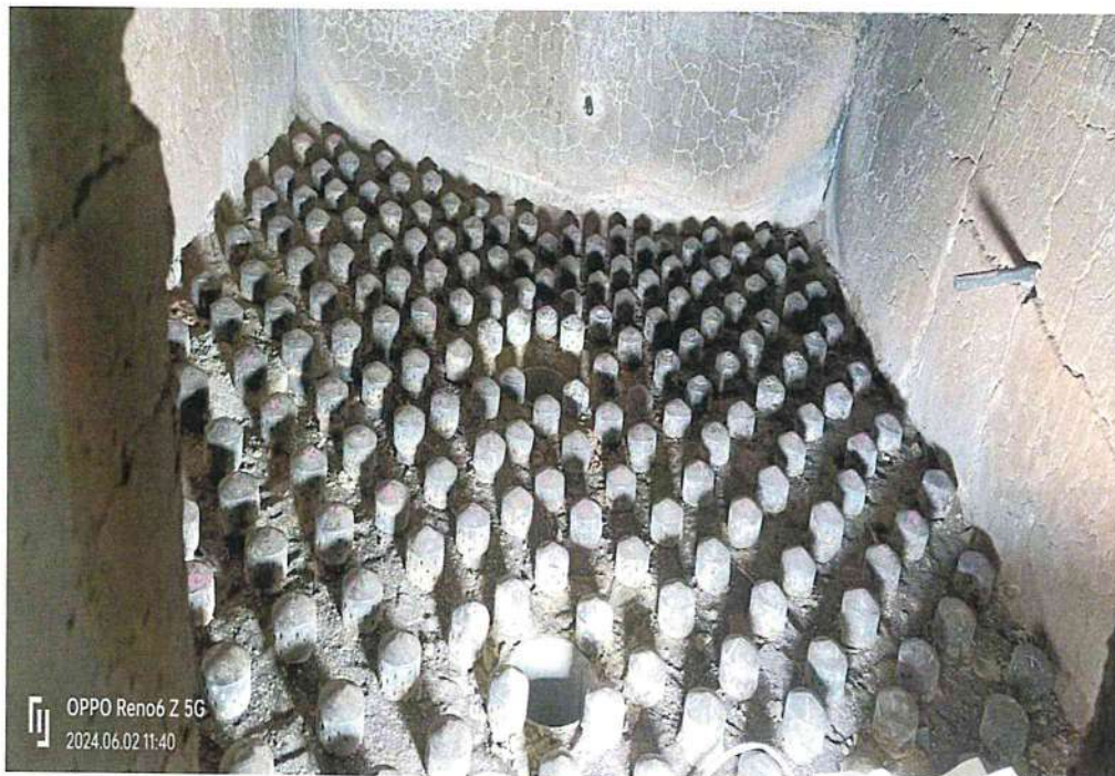
สภาพ Air nozzle ใน Furnace
